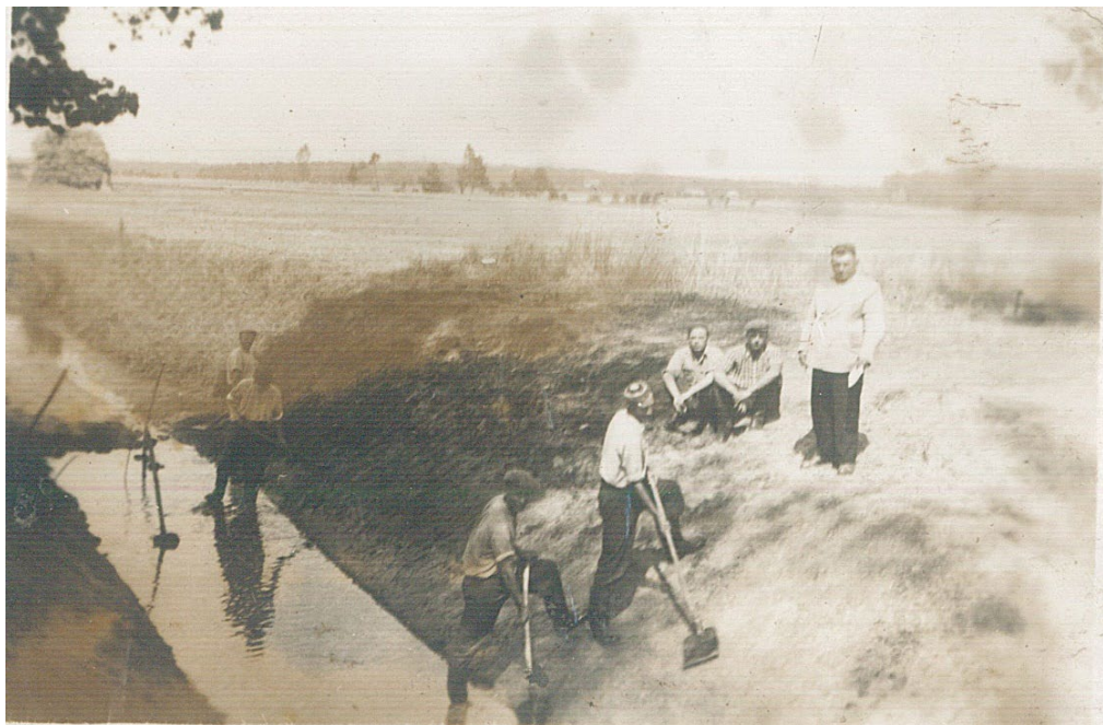
Prace konserwacyjne na rzece Teleszynie w Głuchowie. Pierwszy od prawej (stoi) Tomasz Klimczak - ojciec p. Jadwigi
