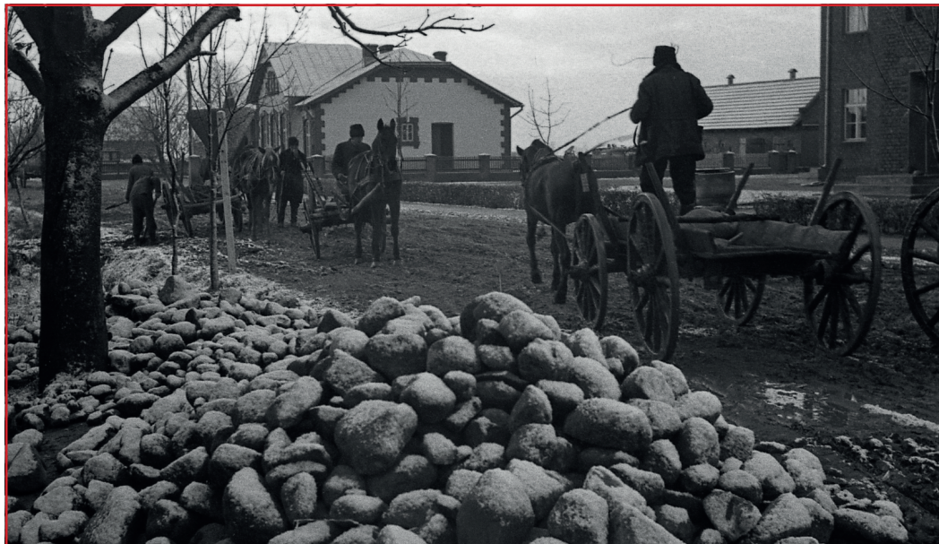
Kowale Pańskie budowa drogi w centrum wsi rok 1941.
