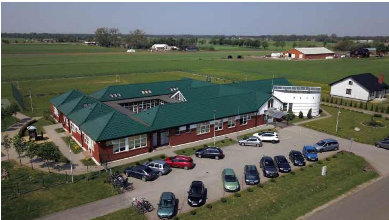
Budynek nowej szkoły w Tokarach oddanej do użytku w 2010 r.
