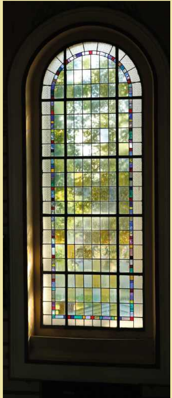
Okno wypełnione szkłem witrażowym
